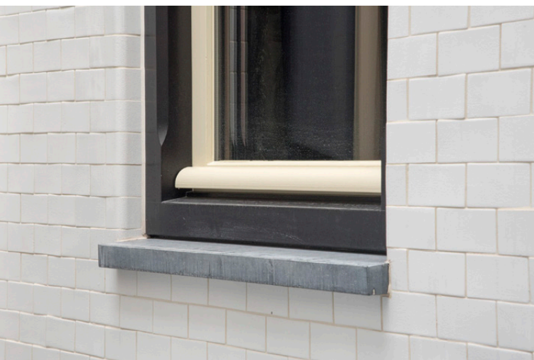
Buitengevel binnenplaats ook keramisch bekleed
